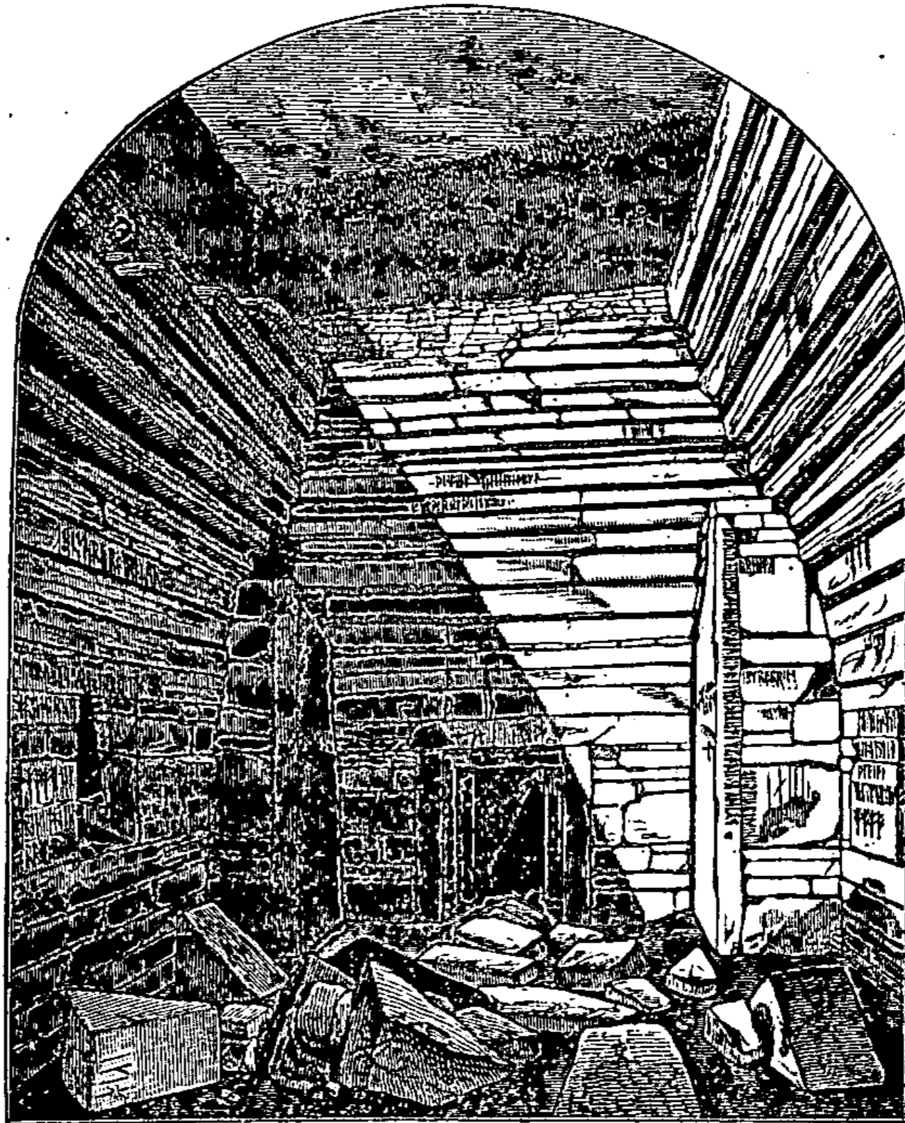
Fig. 88. — Vue de la chambre de Maes-Howe.
