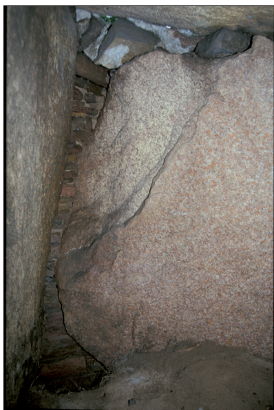
Fig. 6 : Le dolmen à couloir de Flintinge Byskov dont un angle de l'orthostate s'est cassé lors de l'installation de la dalle de couverture ; la moitié supérieure de la maçonnerie en pierres sèches est une réparation effectuée au Néolithique après l'endommagement de l'orthostate. Cependant, la pierre la plus haute et celles qui se trouvent dans le mortier directement sous la dalle de couverture ont été installées là dans les temps modernes.
